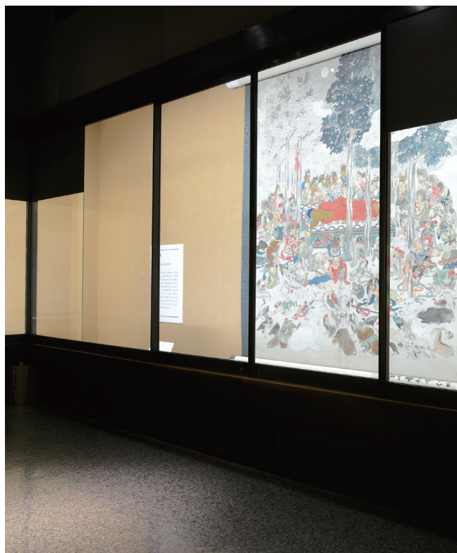
写真 昔の展示ケース。フレームが鑑賞の妨げとなっている。
