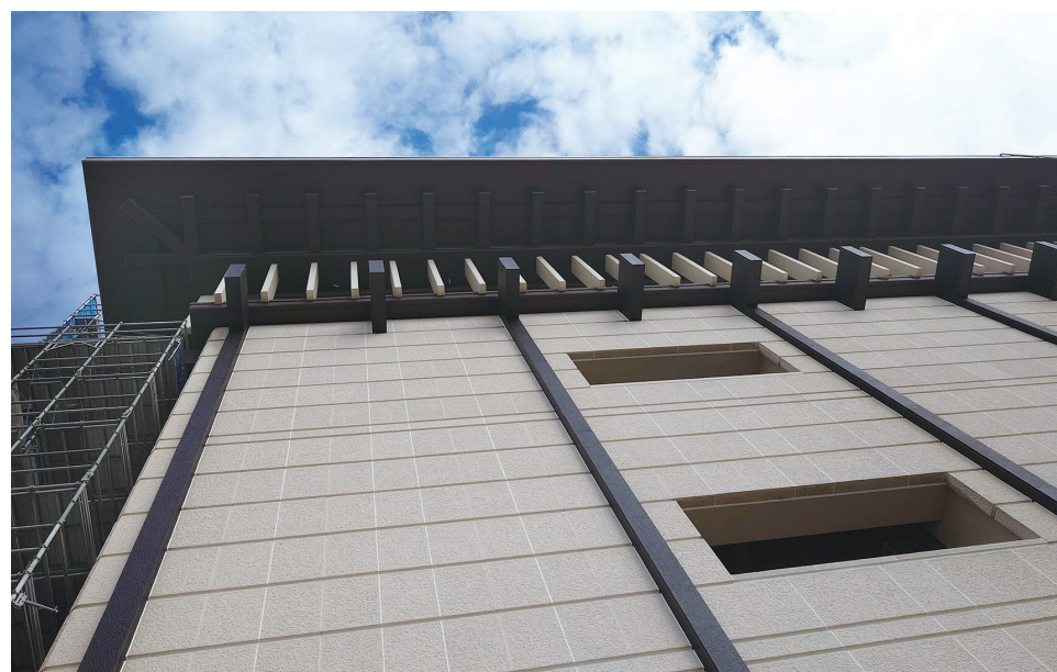
写真1 足場解体中の南側外壁 左上はリニューアル前の外壁
