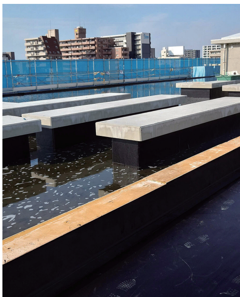
写真4 屋上工事風景
