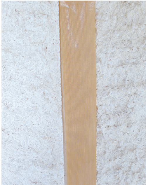
写真1 洗浄前(右)、洗浄後(左)の外壁パネル
