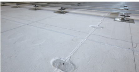
写真4 東館（仮称）床部材（ALC）
