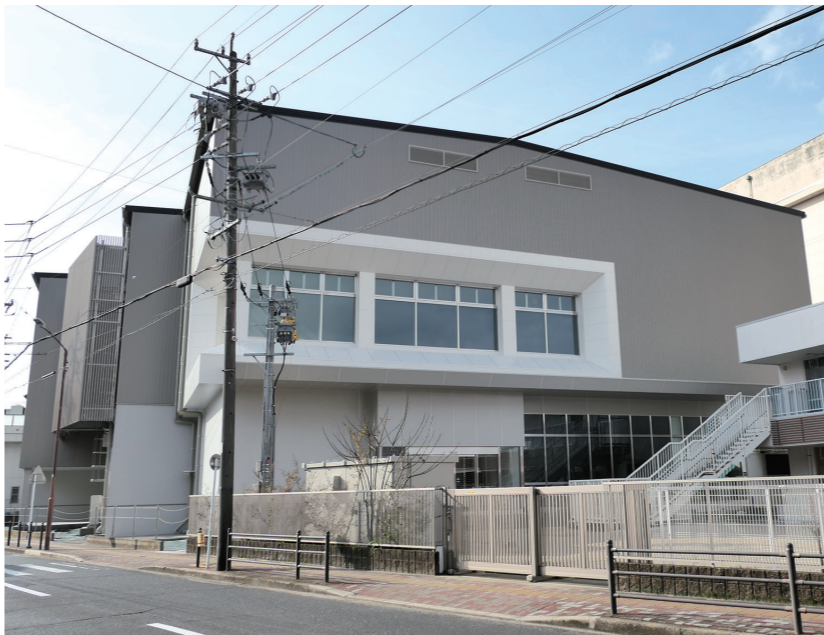
写真3 東館（仮称）外観
