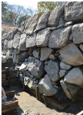
名古屋城本丸御手北石垣とその土台木 名古屋城総合事務所提供
